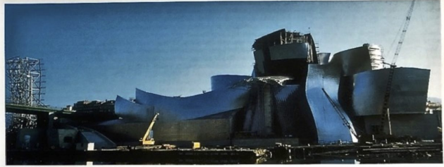
Frank O. Gehry, Guggenheim Museum, 1997, Bilbao.
